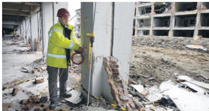
Een van de drie springmeesters verbindt de springstof in de pilaren met elkaar met draden. foto Jurriaan Balke
